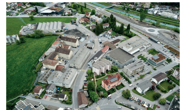
Bahnhofstrasse, Mühlhäusern 8752 Näfels
